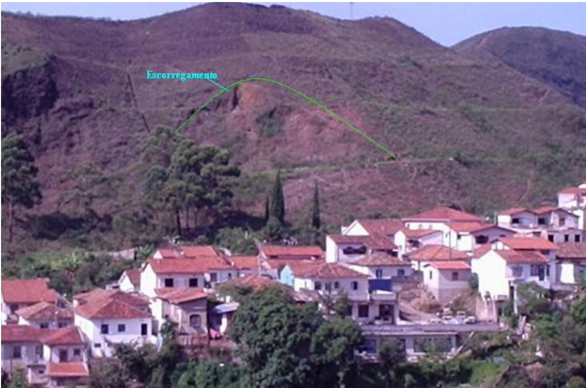
Figura 1: Talude estudado, mostrando escorregamento.
