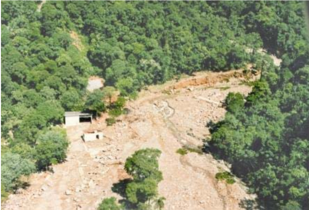
Figura 3: Resultado de corrida de lama e detritos que atingiu instalações da Petrobrás no ano de 1984
