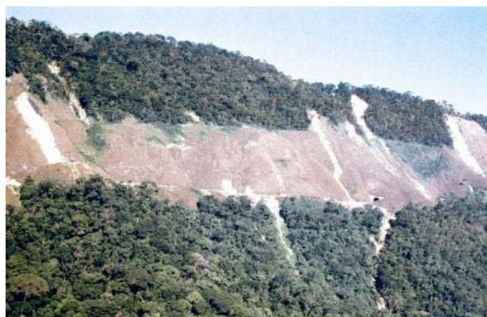
Figura 7: Erro idêntico cometido pela engenharia brasileira no trecho Serra do Mar da Estrada de Ferro Sorocabana. Notar os inúmeros escorregamentos associados a esse desmatamento.
