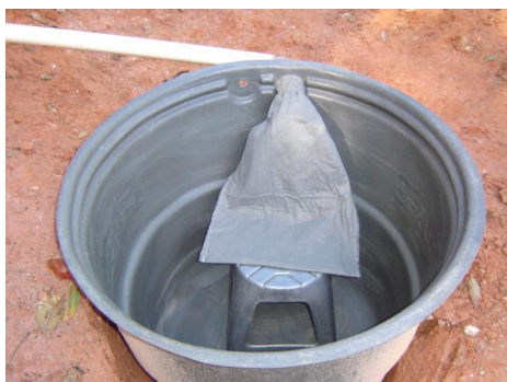
Figura 3: Tanque com o saco de geotêxtil
