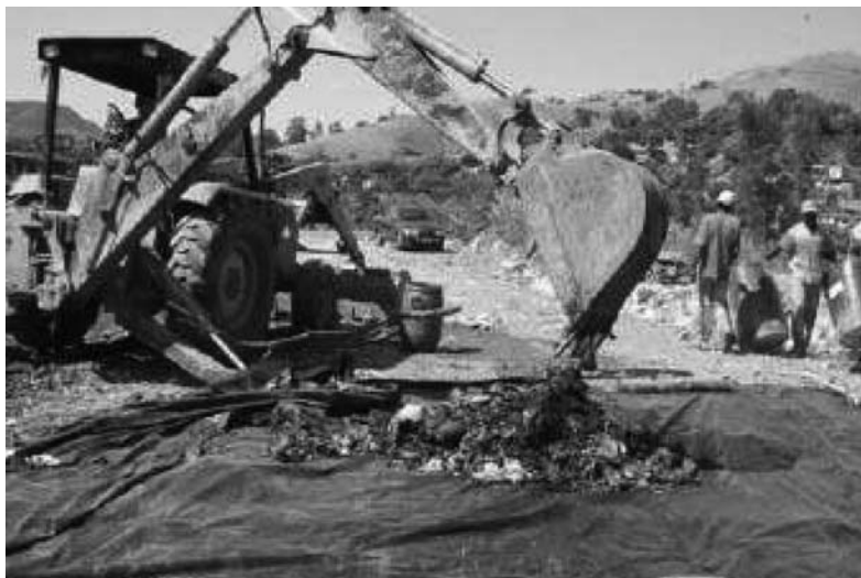
Fig. 12 – Retirada do material com a retro (Silveira, 2004).
