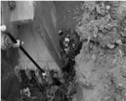
Fig. 7 – Foto à esquerda: em destaque a cavadeira especial de extração; Foto à direita: o enxadão corrente e ganchos de extração.
