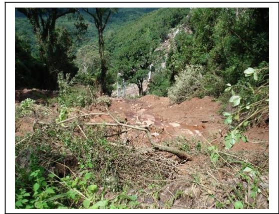
Figura 5. Vista do topo da ruptura na lateral do primeiro talvegue.
