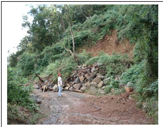
Figura 4. Vista da ruptura do caso 2(c).
