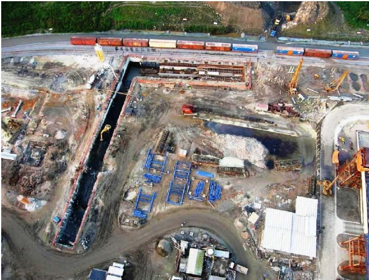
Contenções para construção da moega rodo-ferroviária e galeria de alimentação dos armazéns do Terminal de Granéis.
