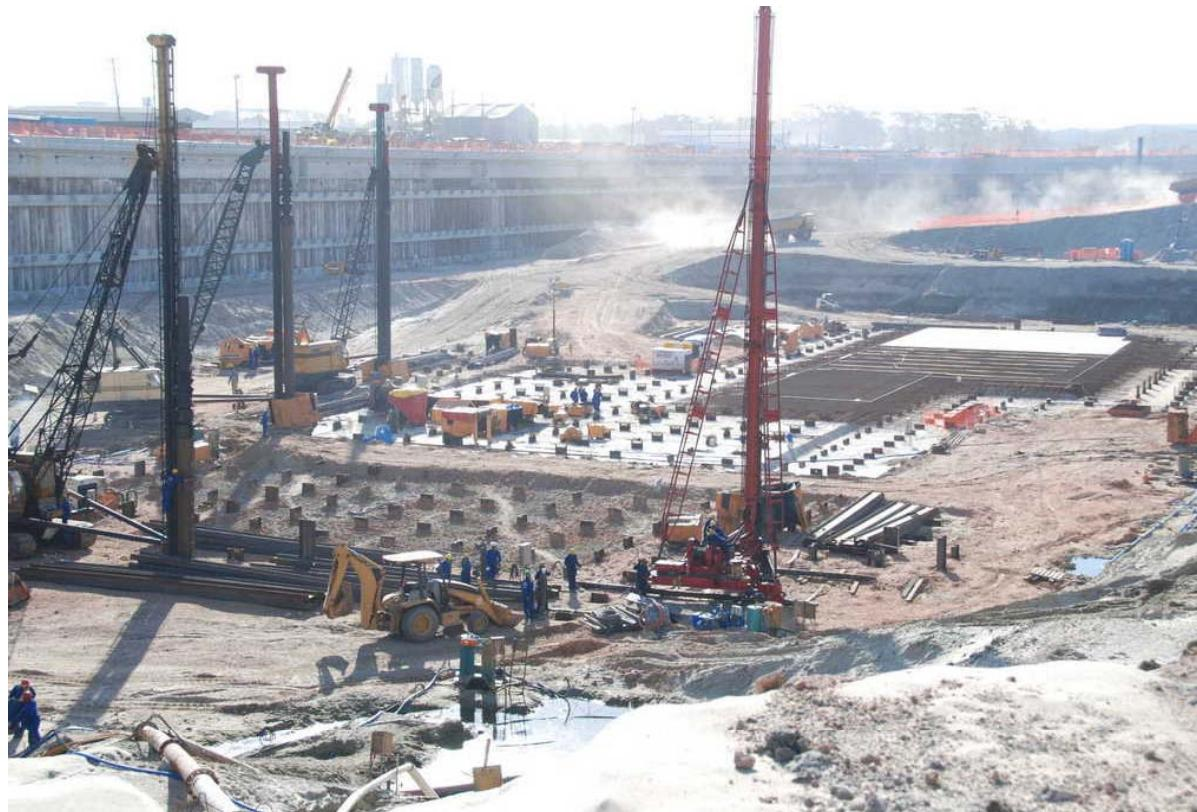
Doca Seca: dimensões 133m x 350m x 17m (3,3m acima no nível d'água e 13,7m abaixo do nível d'água);
