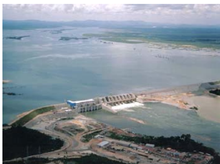
Vista aérea da barragem
